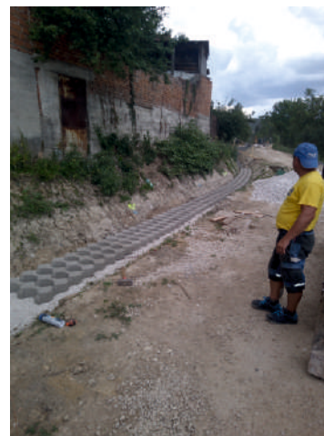
Práce na realizácii úprav potoka Mlynský náhon (Hydroekol).
