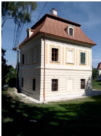
Ukončenie reštaurátorských prác na fasáde západného pavilónu.
